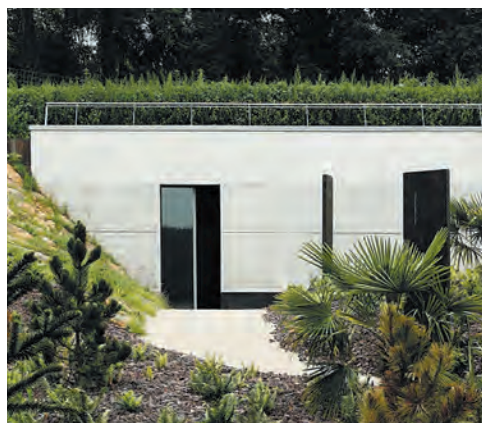
Toiture-terrasse jardin avec isolation Knauf Therm ATTIK Se et drainage Knauf Hysoldrain®
