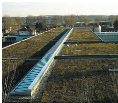
Toiture-terrasse végétalisée avec isolation sur Knauf Therm TTI Se
