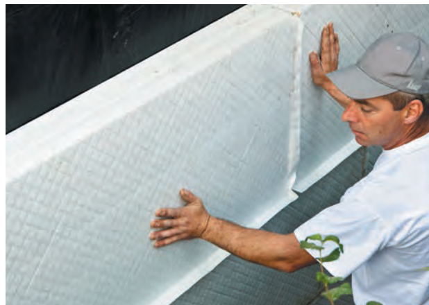
Emboîtement et serrage des panneaux de Knauf Therm Perimaxx® entre eux
