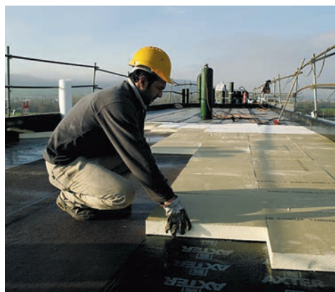
Pose libre des panneaux Knauf Thane ET Se sur le pare-vapeur
