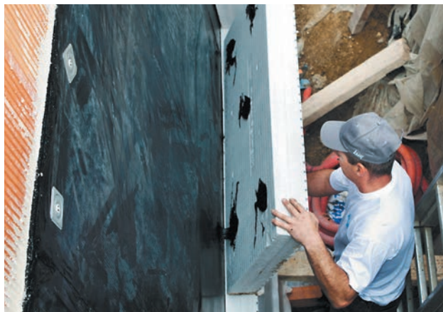
Collage des panneaux de Knauf Therm Perimaxx® sur le support, de bas en haut
