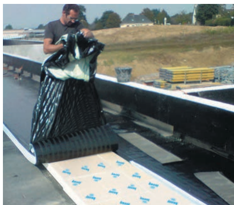
Revêtement d'étanchéité semi-indépendant par auto-adhésivité sur Knauf Thane MulTTI Se
