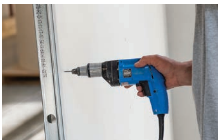
Vissage des plaques Knauf HydroProof®
